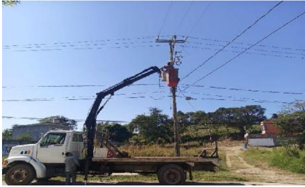
Mantenimiento de alumbrado público en diferentes comunidades del municipio de Axtla de terrazas.
