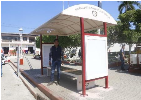
Construcción de parada de taxis en plaza principal.
